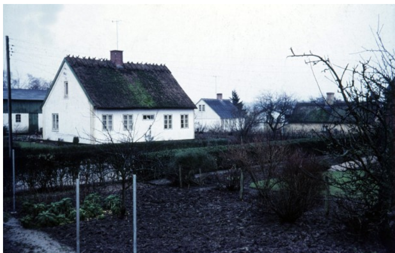
Et kig ned ad Grønnevej i 1960.
